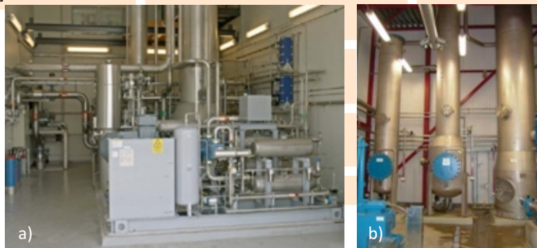
Rys. 22. Instalacja uszlachetniająca (600 m 3 /h) z technologią płuczki wodnej w oczyszczalni ścieków w Henriksdal - Sztokholm (a), Płuczka uszlachetniająca biogaz w biogazowni w Västerås - Szwecja (b).
