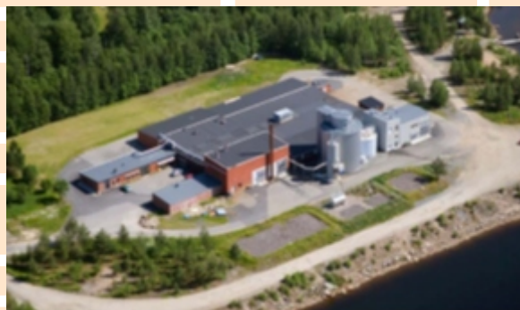
Rys. 6. Biogazownia w Boden.
