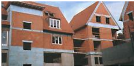
Struktura mieszana – utrudniona redukcja mostków termicznych
